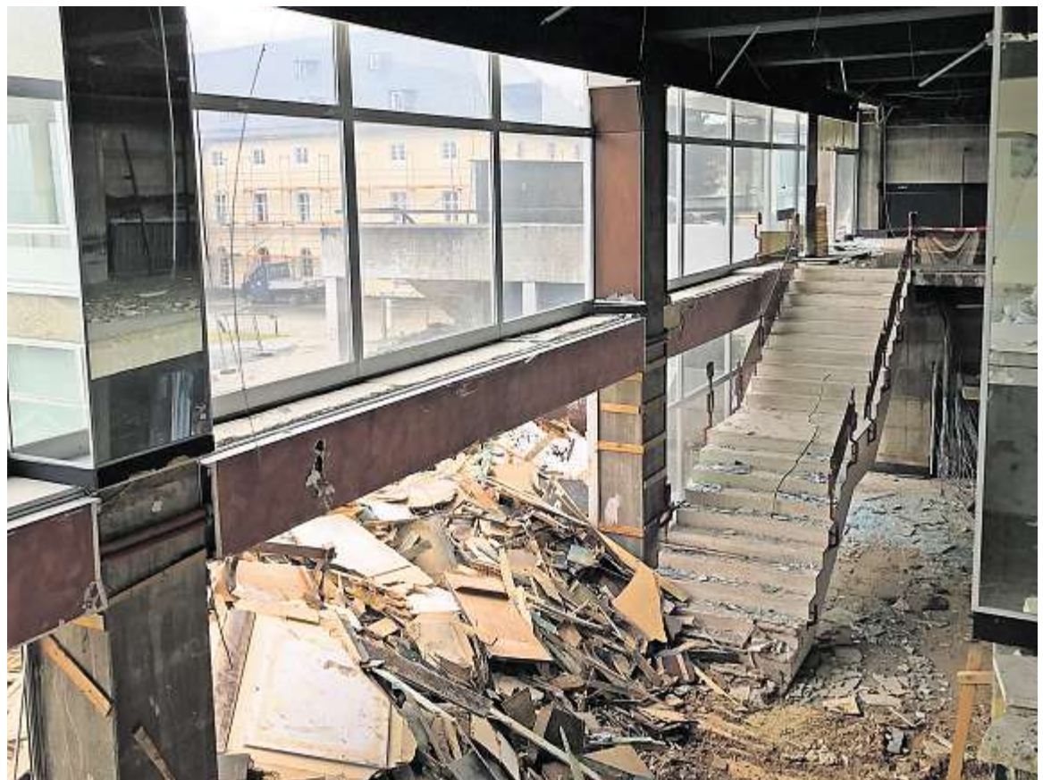
Das einst so stolze Kur- und Sporthotel in Bad Alexandersbad ist mittlerweile weitgehend entkernt. Demnächst beginnt der richtige Abriss.
