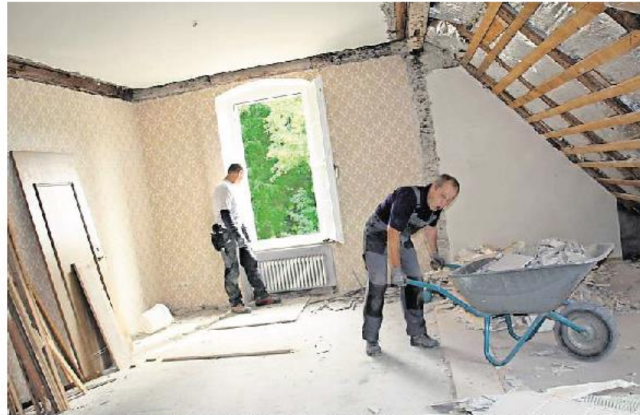
Die alten Tapeten hängen noch an den Wänden, doch die Mitarbeiter des Bauhofs, Günther Kachgruber und Petr Krejci, werken fleißig daran, dass hier demnächst vier neue Wohnungen im Schloss entstehen. Foto: zys
